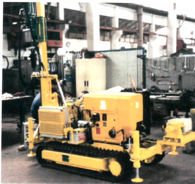
Figure 24 : Forage à la sondeuse mécanique
